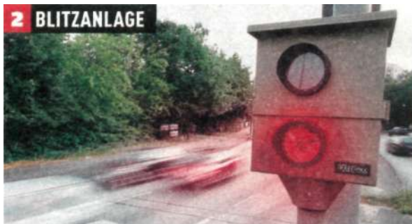
2 BLITZANLAGE Blitzer: An einer Ampel blitzt er zweimal. So wird festgestellt, ob der Wagen eine Kreuzung tatsächlich bei Rot überquert hat
